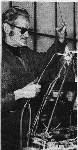
Das Velo steht und fällt mit der Lötstelle: In der Velorahmenfabrik werden die Rohre sorgfältig zusammengelötet.
